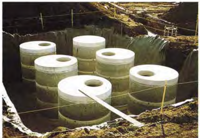
地下貯留施工例
