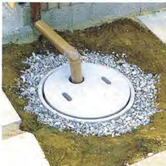
住宅用浸透ポラコン 枳施工例
